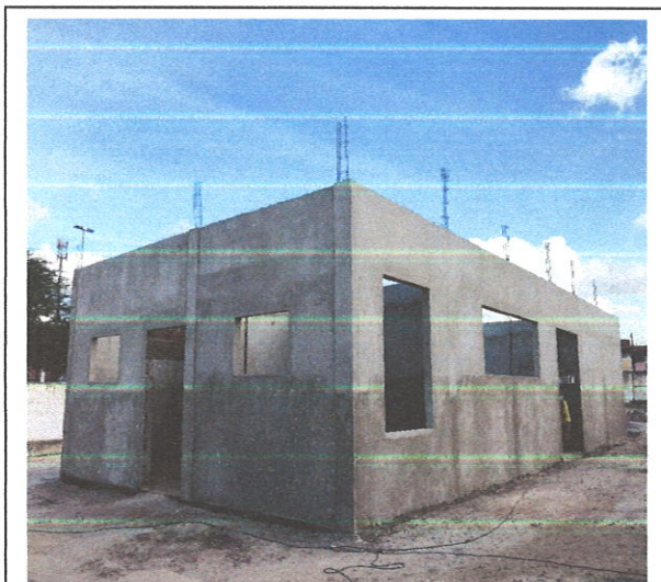
FOTO 71: Reboco (bloco 2)
