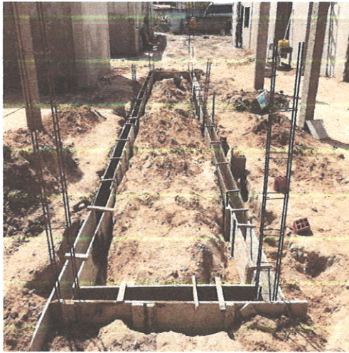
FOTO 77: Vigas baldrame da jardineira (bloco 1)
