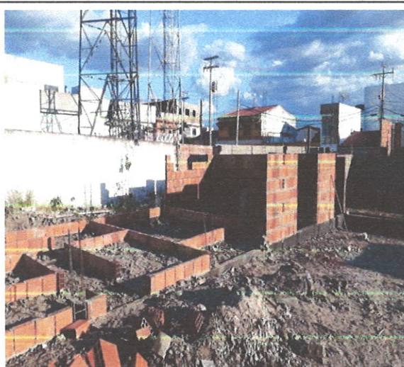
FOTO 61: Levante de alvenaria (Bloco 3)
