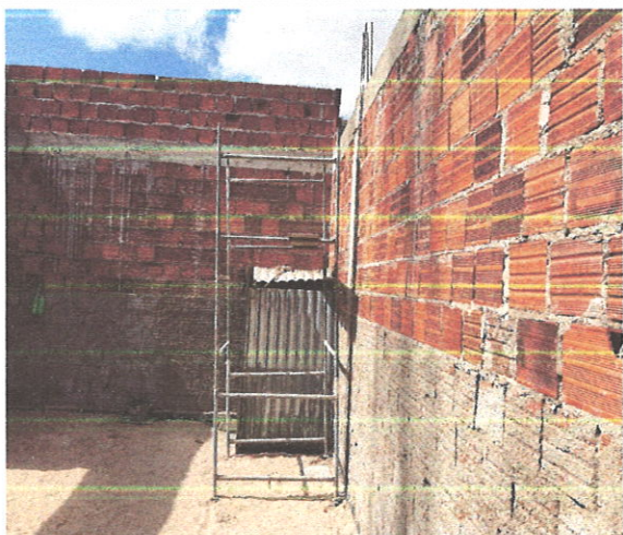
FOTO 65: Levante de alvenaria da platibanda (bloco 1)
