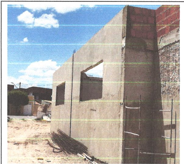
FOTO 69: Reboco (bloco 2)
