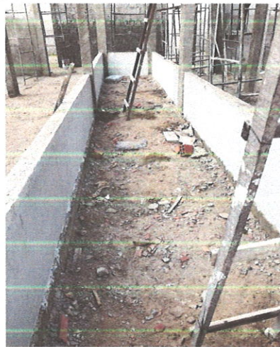
FOTO 79: Reboco e impermeabilização da jardineira (bloco 1)
